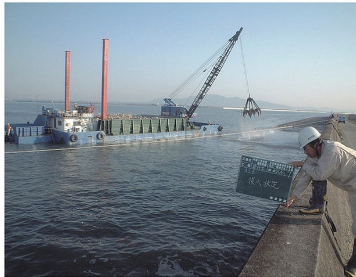
熊本県・玉名横島海岸保全事業堤防根固。(平成 15 年)
