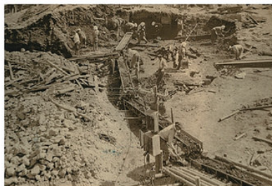
ベルトコンベアによる土砂の運搬作業。（昭和30年頃）
