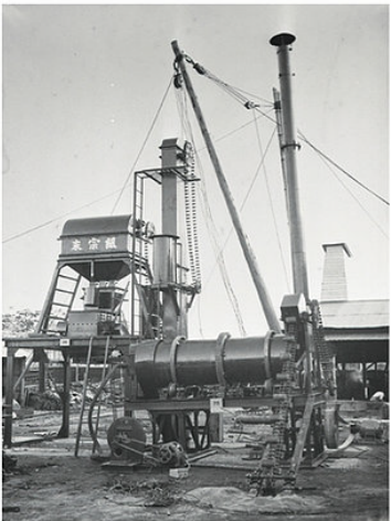
末宗組の先見性を示したアスファルトプラント。
