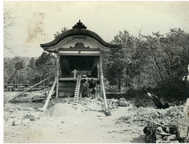
昭和27年、寄藻川の改良工事（上）と、呉橋の架け替え工事（下）。
