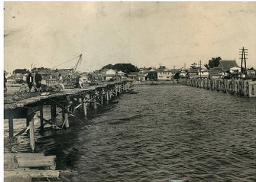
創業4年目にして、当時の県下主要河川の一つ、小松川の修繕工事を任せられた。
