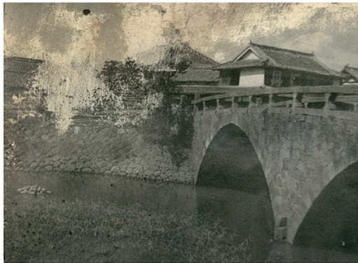
寄深川にかかっていた猫間橋。向こうに末宗組の本屋が見える。（大正10年頃）
