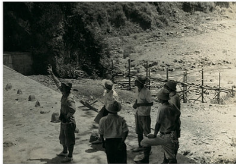
由布岳崩壊により、昭和 28 年、戦川砂防ダム工事に着工。
