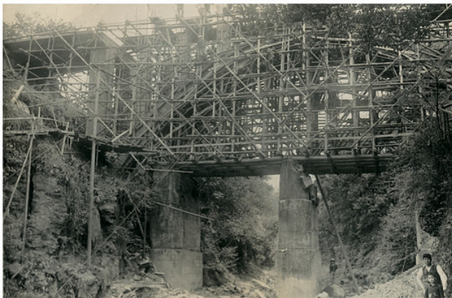
旧大野郡の下田橋架け替え工事。（昭和 25 年）
